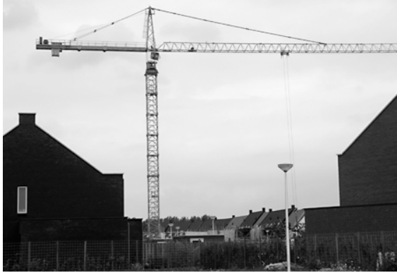
de complete bouwkraan
