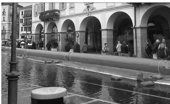
De Tubewall bestaat uit een flexibele kunststof buis (zoals de binnenband van een fiets). Aan de buis zit een flap van hetzelfde materiaal waarop het water drukt.
