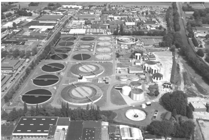
Figuur 7: Rioolwaterzuiveringsinstallatie Apeldoorn
